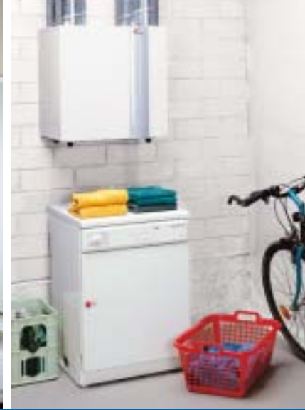
Installation des Zentralgerätes im Keller.
